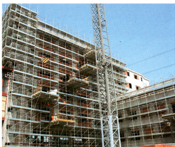
L'edificio in corso di ristrutturazione e come sarà a lavori ultimati.
